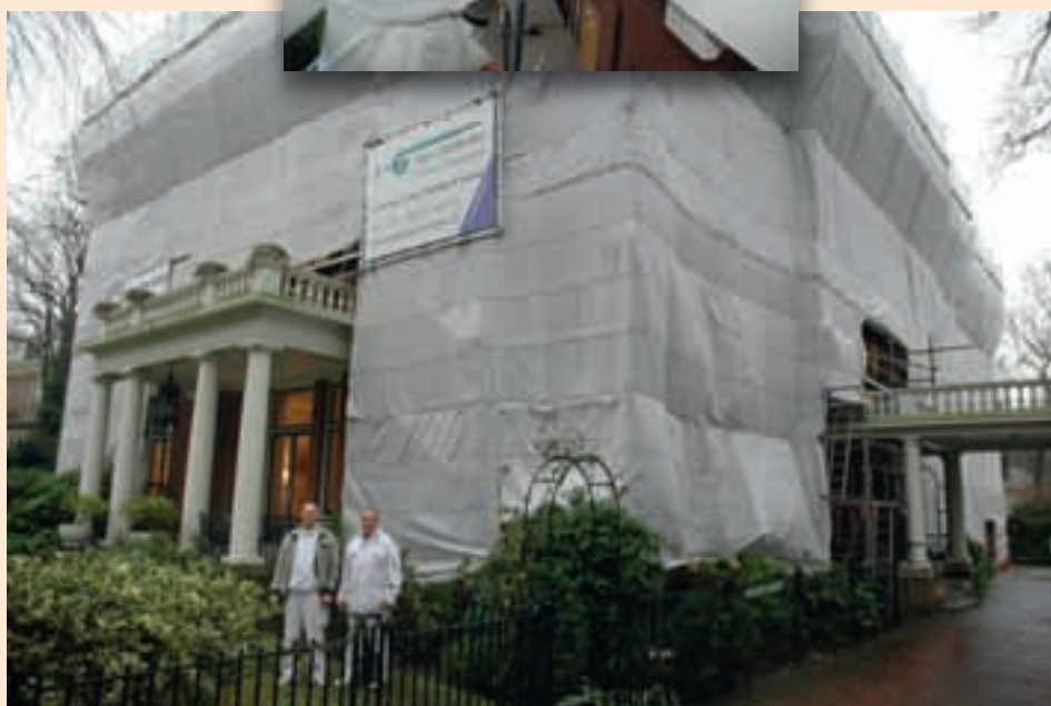
Dankzij het hoofdgebouw van CNV Publieke Zaak overbrugt ‘Schilders- en Afbouwbedrijf Van Gelderen’ de hele winter (inzet: Ronald van Gelderen en Michel Remmerswaal bij de dakrand van het monumentale pand, die eerst helemaal is afgekrabd)
